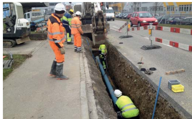
Verlegung der Hauptwasserleitung NW 150 entlang der Kantonsstrasse K242
