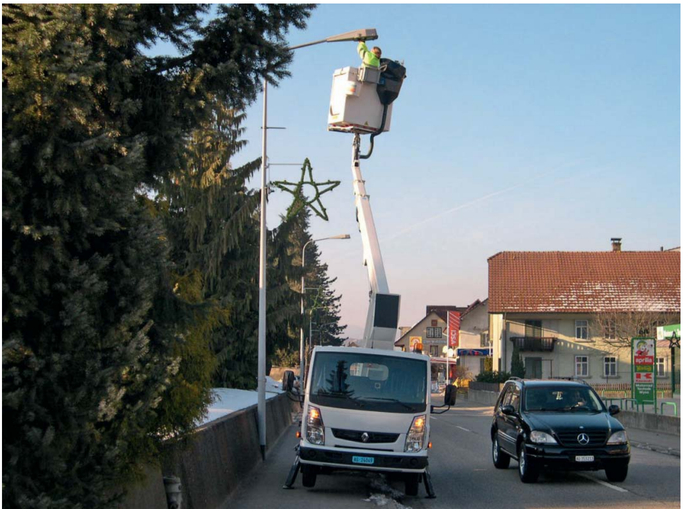
Unterhaltsarbeiten an Strassenleuchte Kantonsstrasse K242
