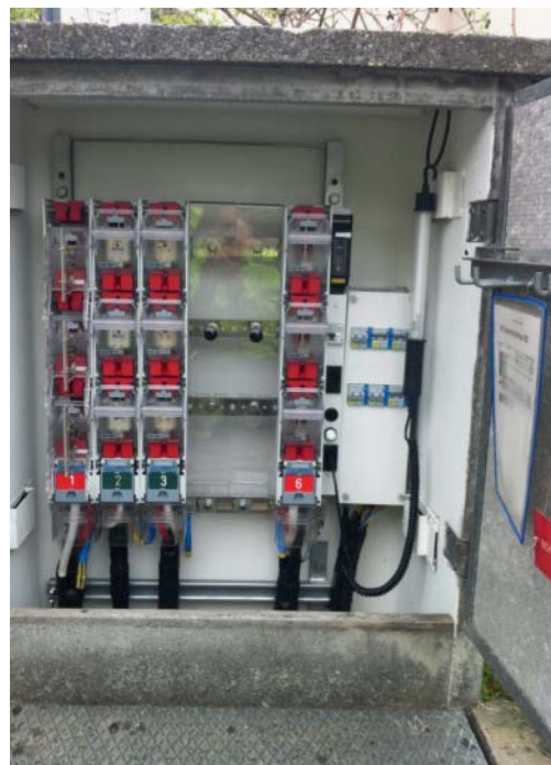
... und nach dem Umbau
